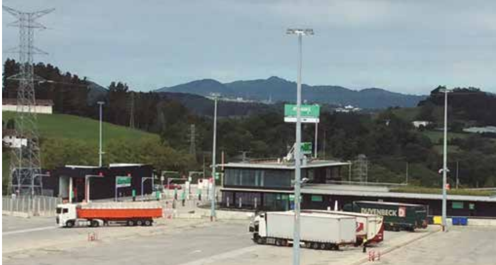
Imagen de las instalaciones del aparcamiento de Astigarraga.
